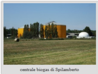
centrale biogas di Spilamberto
