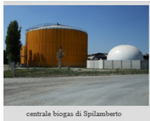
centrale biogas di Spilamberto
